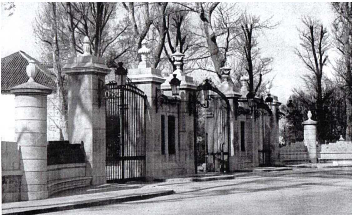
DOCUMENTO 19 Modificaciones de 1948 con la incorporación de los pilonos cilíndricos de Isidro Velázquez en los extremos.
