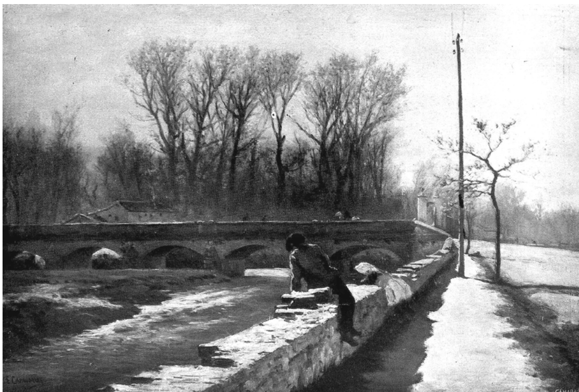
DOCUMENTO 4 “Puente del rey, sobre el Manzanares”, cuadro de Casasnovas anterior a 1921 donde se ve la situación de los pilonos cilíndricos de la embocadura.
