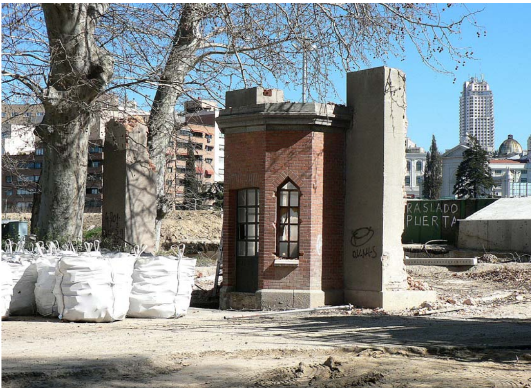
DOCUMENTO 22 El garitón norte, antes de su demolición. La cuidada cantería de granito y piedra de Colmenar de los dos garitones ha desaparecido y se desconoce su paradero.
